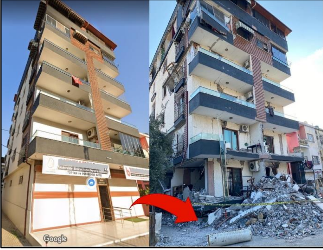
Şekil 8. Yumuşak kat etkisi ile zemin kattaki göçme öncesi ve sonrası (İskenderun, Fotoğraf; A.Ferdi Şenol).
