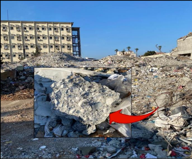
Şekil 12. Beton karışımında uygun olmayan agrega kullanımı (İskenderun, Fotoğraf; A. Ferdi Şenol).
