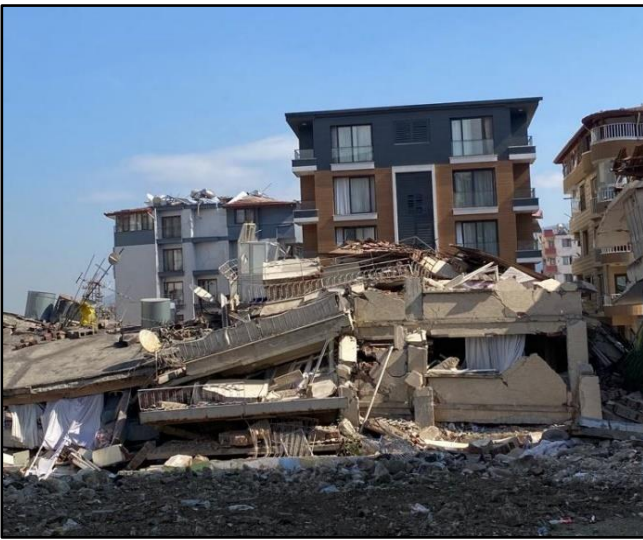
Şekil 1. Bina katlarının çökmesi (Antakya, Fotoğraf; A.Ferdi Şenol).
