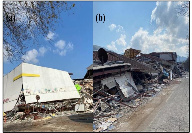
Şekil 10. Bitişik nizam etkisi (Antakya, Fotoğraf; A. Ferdi Şenol).
