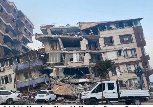
Şekil 11. Uygulama Kaynaklı Hasarlar- Deprem Derzi
