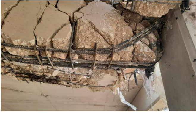
Şekil 12. Uygulama Kaynaklı Hasarlar- Kolon Kiriş Birleşimi
