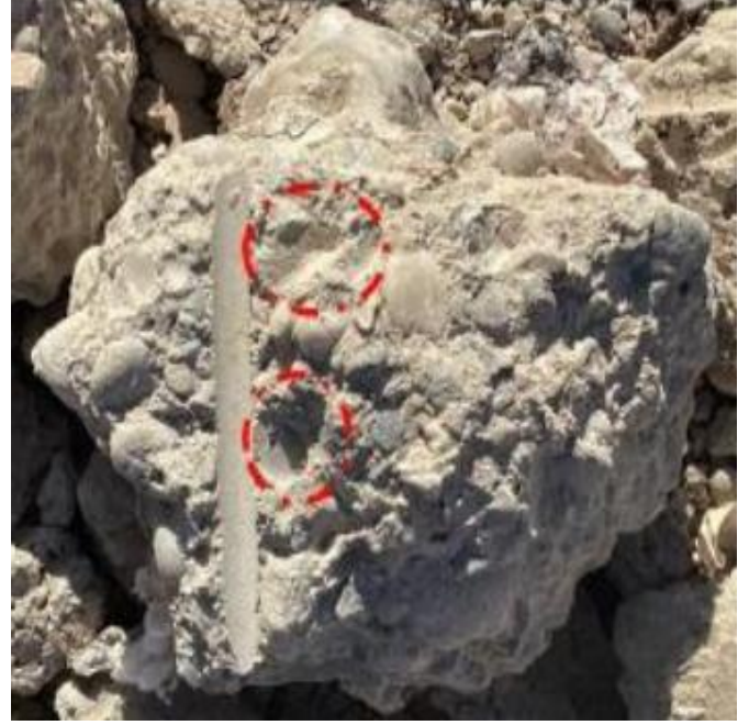
Şekil 6. Malzeme Kaynaklı Hasarlar – Beton
