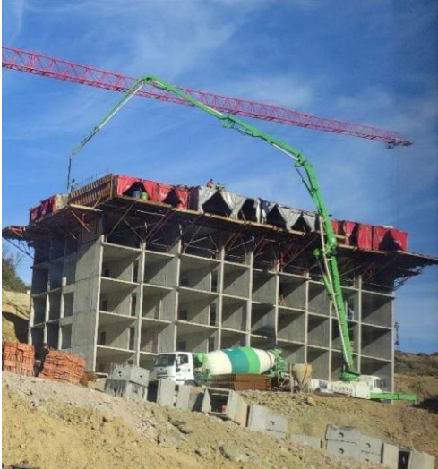
Şekil 5. Tünel Kalıp Sistemi ile Yapı İnşası (Ahmet Hasan DUMAN)
