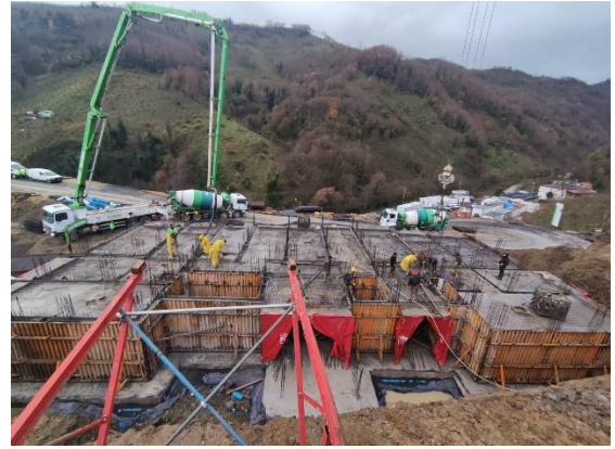
Şekil 9. Tünel Kalıp Sisteminde Beton Dökümü [19]
