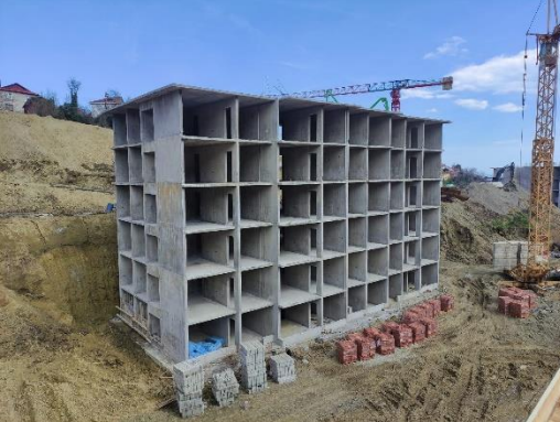
Şekil 12. Tünel Kalıp Sistemi ile İnşa Edilmiş Yapı Örneği (A. Hasan DUMAN)
