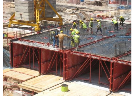
Şekil 6. Tünel Kalıp Sistemi Kurulumu ve Hazırlanması [27]
