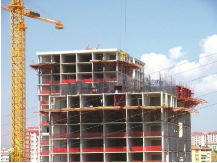
Şekil 4. Tünel Kalıp Sistemi ile Çok Katlı Yapı İnşası [27]
