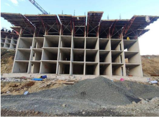
Şekil 11. Tünel Kalıp Sistemi ile İnşa Edilen Kalıpları Sökülecek Yapı Görseli (A. Hasan DUMAN)
