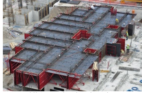
Şekil 1. Tünel Kalıp Sistemi [27]
