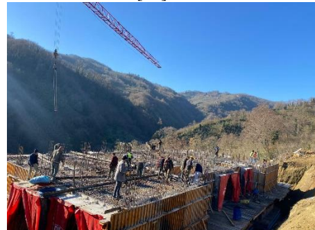
Şekil 7. Tünel Kalıp Sistemi Kurulumu ve Hazırlanması (A. Hasan DUMAN)
