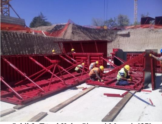
Şekil 3. Tünel Kalıp Sistemi Montajı [27]
