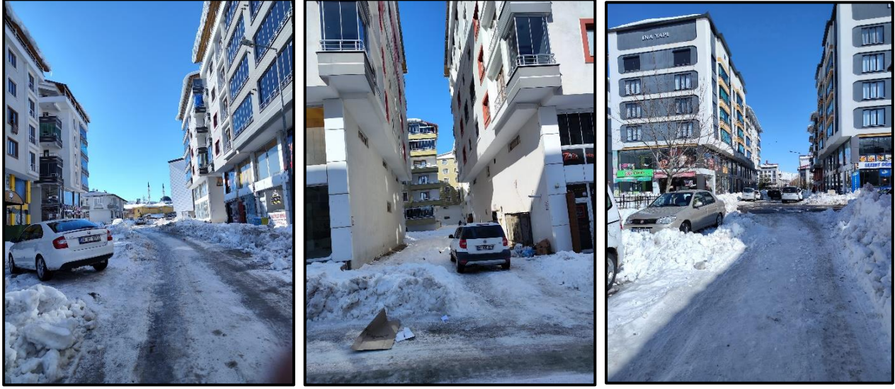
Şekil 4. İnceleme alanında kentsel dönüşüm uygulanmış alanlardan görüntüler
