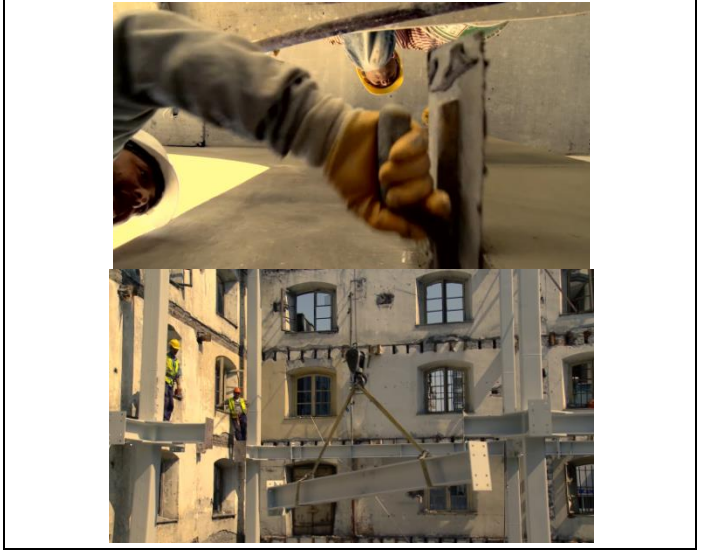
Şekil 14. Cephe yenileme çalışması [17]
