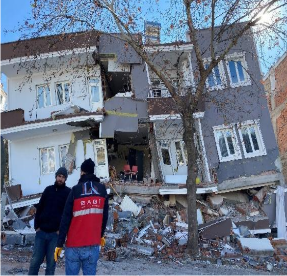
Şekil 9. Yumuşak/Zayıf Kat Kaynaklı Yapısal Hasar Örnekleri
