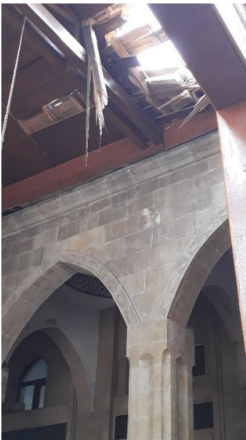
Şekil 9. Arasa Camii ahşap çatısı
