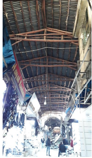
Şekil 10. Kapalı çarşı ahşap çatı
