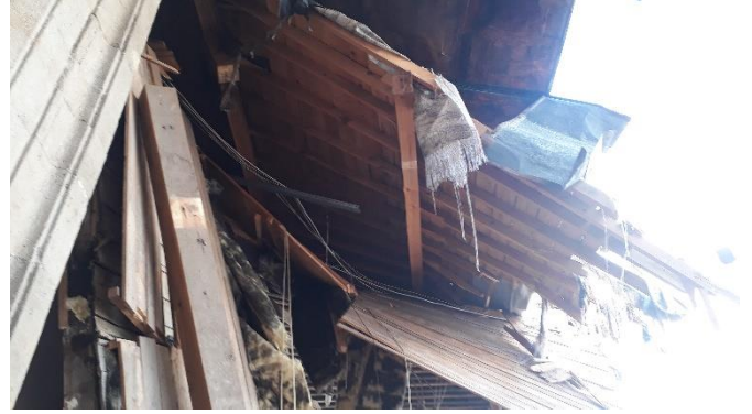
Şekil 5. Ulu Caminin hasar gören ahşap çatısı
