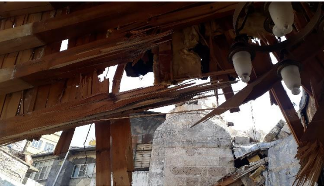
Şekil 3. Boğazkesen Camii ahşap taşıyıcılar
