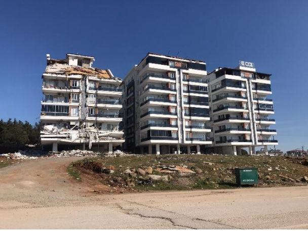
Şekil 16. 6 Şubat 2023 Kahramanmaraş depremlerinden sonra Hatay'da yapı-temel-zemin uyumsuzluğu nedeniyle ağır hasar alan yapının örneği
