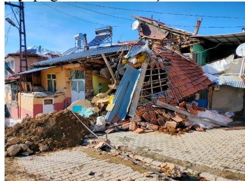
Şekil 4. 6 Şubat 2023 Kahramanmaraş depremlerinden sonra Malatya’da ağır hasar gören yığma yapı
