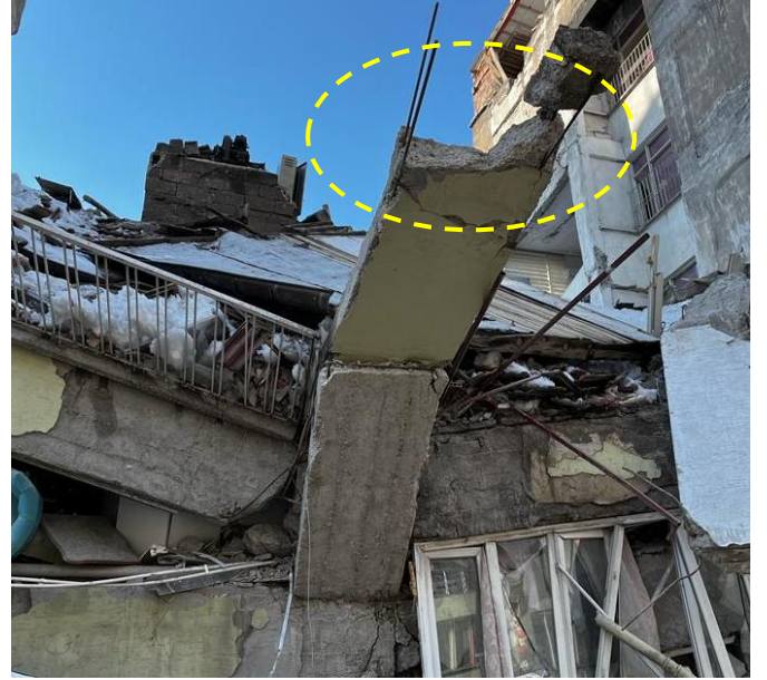
Şekil 16. Donatı türü ve sargı donatısı eksikliğine bağlı hasarlar
