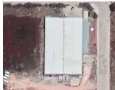
Şekil 5. Örnek Fabrika Çatısı
