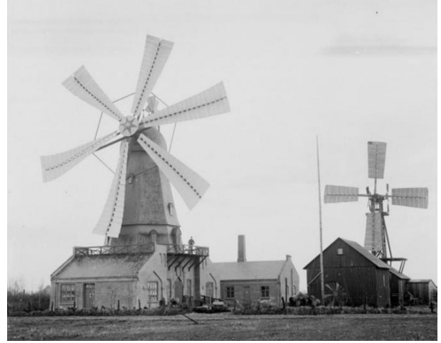
Şekil 6. Danimarka, Askov'daki Poul la Cour'un rüzgâr enerjisi test teçhizatı; sağda: 1891 yılından rüzgâr türbini; sol: 1897'den daha büyük tesis [8].
