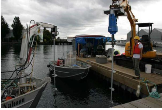
Şekil 8. helisel kazıkların marina yapılarında uygulaması ([10])
