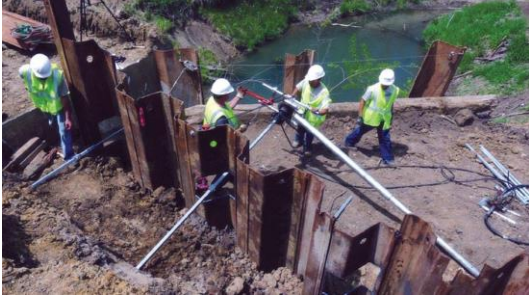
Şekil 9. İstinat yapısı Helisel ankraj montajı ([11])
