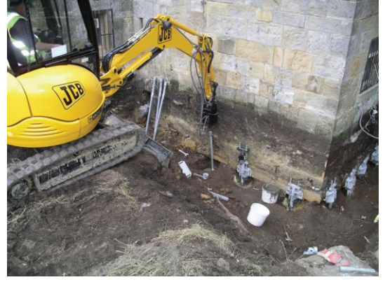
Şekil 10. Tarihi bir yapı temeline helisel kazık kurulumu ([12])
