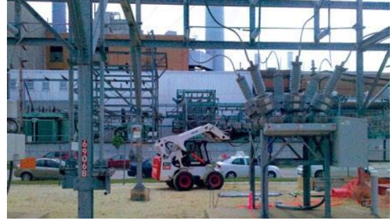
Şekil 11. Mini yükleyici tarafından bir trafo merkezindeki sınırlı alanda helisel kazık imalatı ([11])
